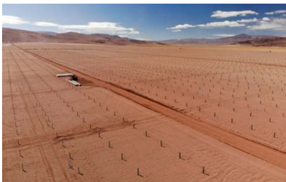
Fig. 1 - Imágenes del Proyecto “Cauchari I-II-III”, en proceso de construcción, de 300 MW de potencia proyectada, situado en la localidad de Cauchari, provincia de Jujuy, República Argentina, (Prensa, Gobierno de Jujuy [5])
