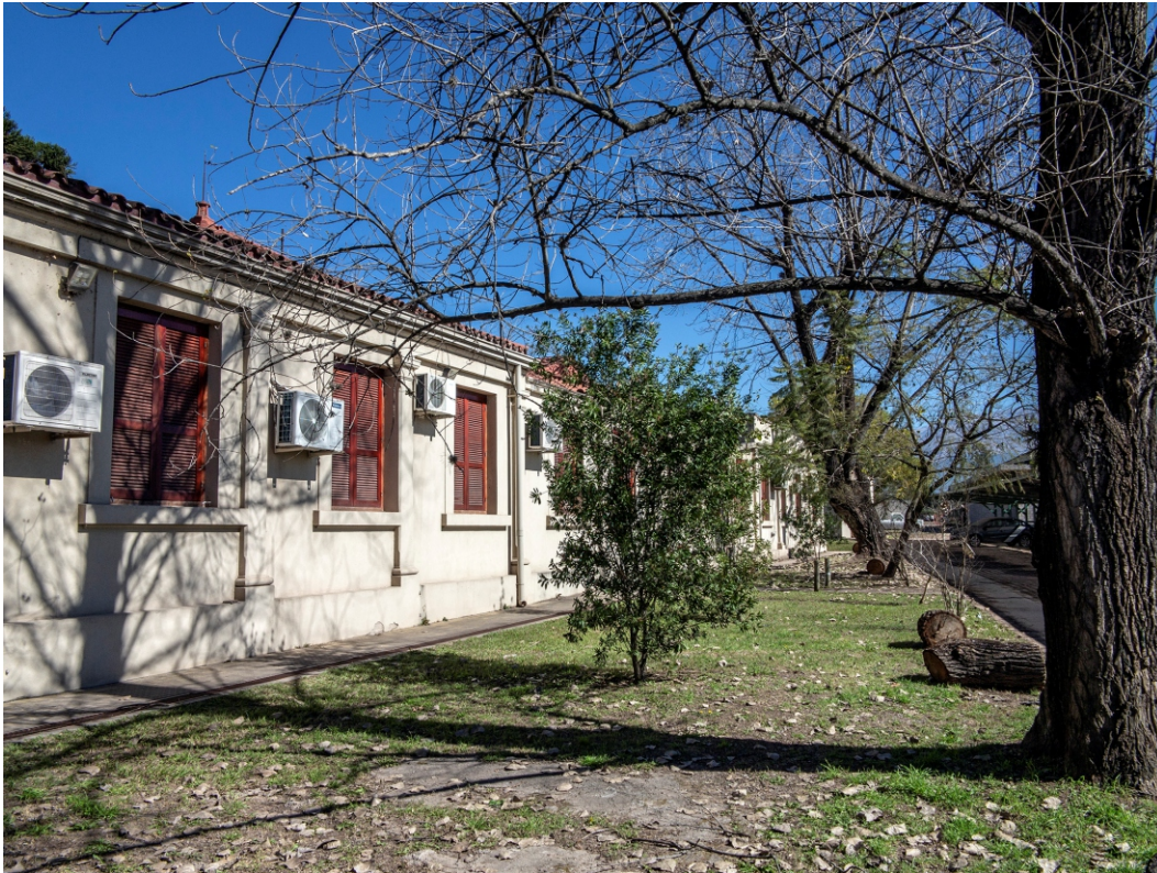
Figura 13. Frente norte con ampliación. Fotografía del autor
