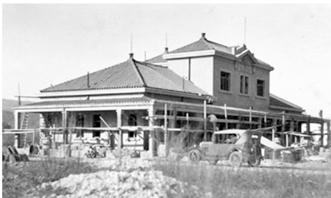
Figura 5. Construcción de la MEPR.A. Archivo Salvador Mazza-AHP-UNJu
