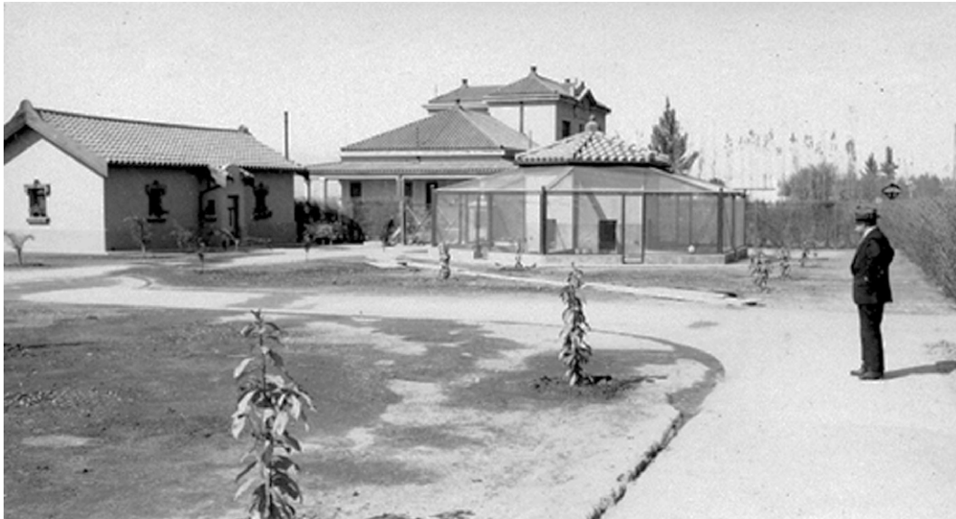
Figura 8. Diseño original de los espacios exteriores de la MEPRA Archivo Salvador Mazza-AHP-UNJu
