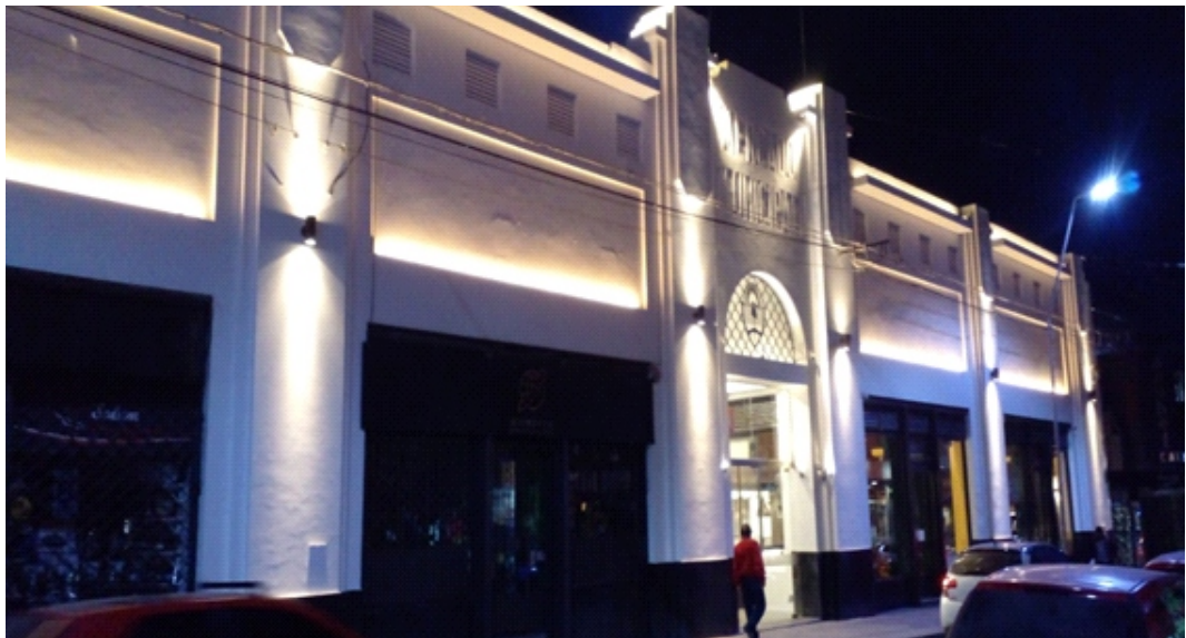
Figura N° 6: Fachada del Mercado 6 de Agosto. Fotografía de la Autora.
