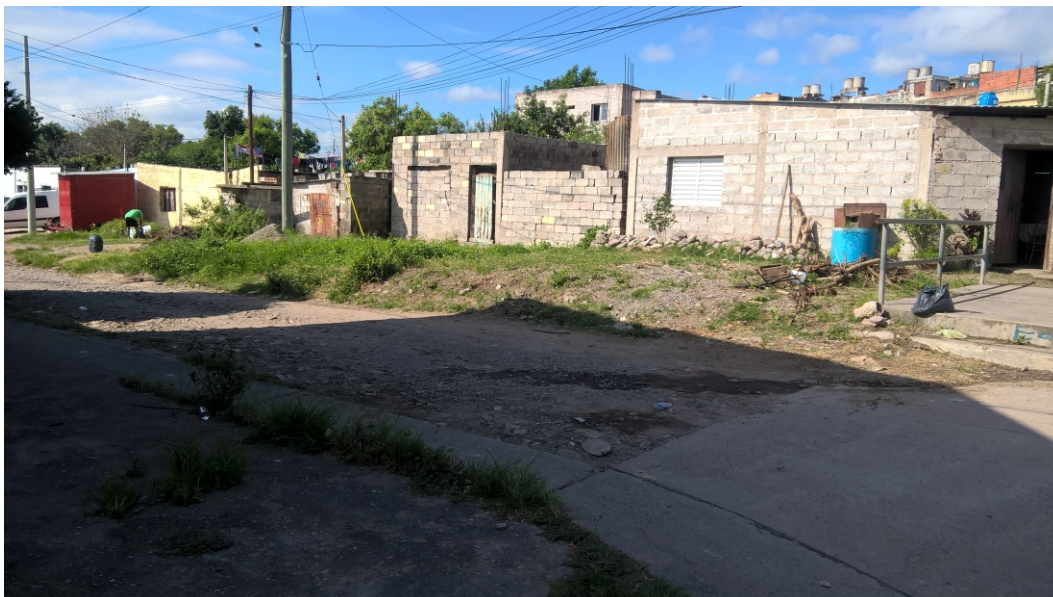
Figura N°8. Viviendas informales. Fotografía: Julio Linares
