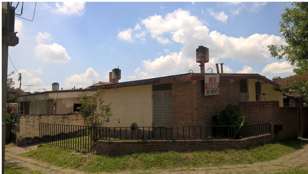
Figura N°5. Vivienda con mínimas intervenciones. Fotografía: Julio Linares
