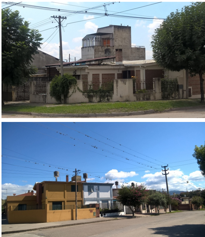
Figuras N°16 y 17. Tipologías de vivienda 2, 3 y 4. Fotografía: Julio Linares
