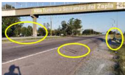
Figura N° 20. Ruta Nacional N° 66, sentido Noroeste-Sudeste. Fuente: elaboración propia (2019).
