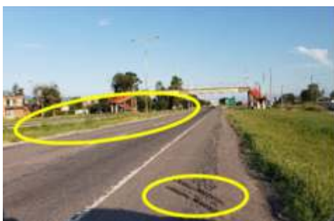
Figura N° 19. Ruta Nacional N° 66, sentido Noroeste-Sudeste. Fuente: elaboración propia (2019).
