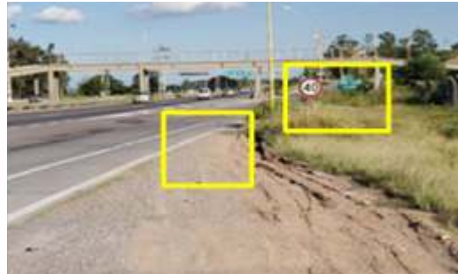
Figura N° 13. Ruta Nacional N° 66, sentido Noroeste-Sudeste. Fuente: elaboración propia (2019).
