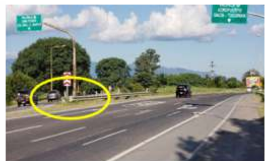
Figura N° 11. . Ruta Nacional N° 66, sentido Noroeste-Sudeste. Fuente: elaboración propia (2019).
