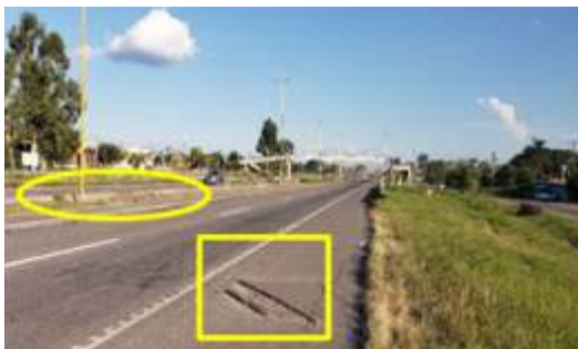
Figura N° 17. Ruta Nacional N° 66, sentido Noroeste-Sudeste. Fuente: elaboración propia (2019).
