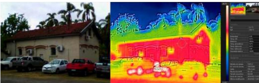
Figuras N°16. Vista exterior simultánea y termografía del frente norte.
