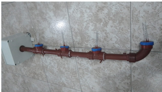
Foto 2. Montaje utilizado para la disposición de los sensores dentro del suelo
