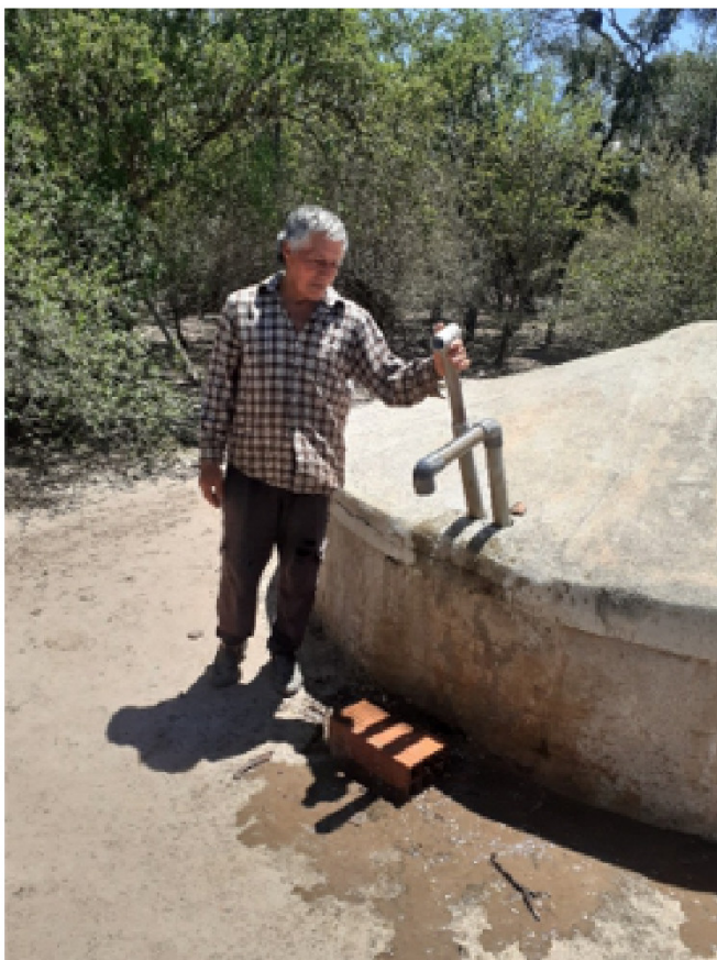
Imagen 2 Sistema de captación del proyecto especial del Ministerio de Desarrollo Social de la Nación (PE 1130/2017)
