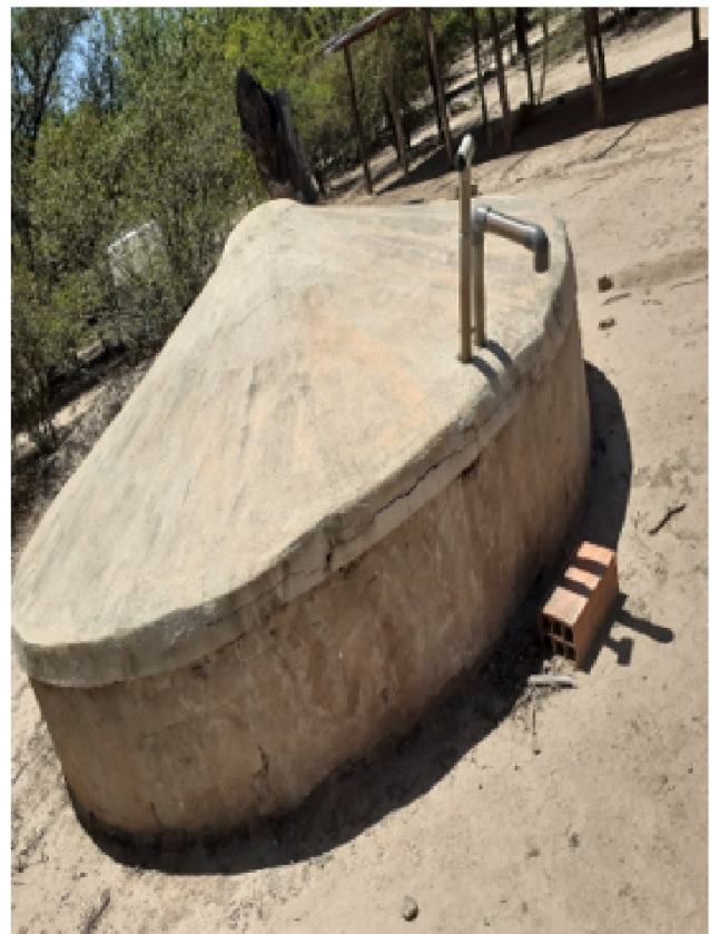
Imagen 3 Sistema de captación del proyecto especial del Ministerio de Desarrollo Social de la Nación (PE 1130/2017)
